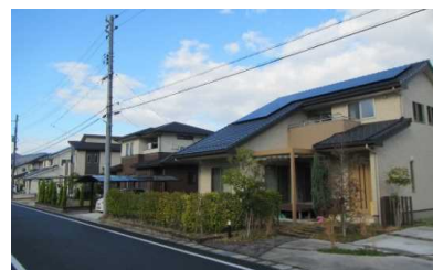
写真：加茂地区の住宅団地
