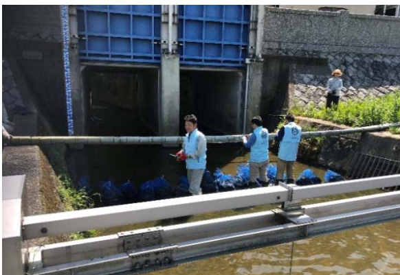
竹炭による河川の水質浄化
