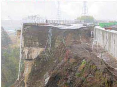
L型擁壁 崩壊・浸食で深礎杭露出
