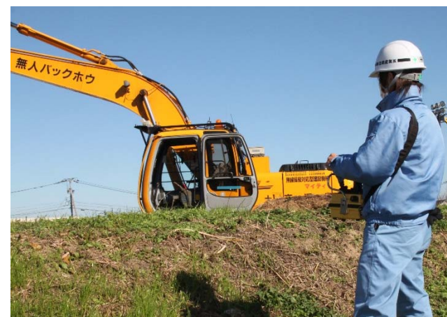
遠隔操縦式バックホウ操作状況
