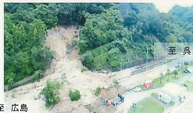
にほ くれ 広島呉道路 (仁保IC~呉IC) の被災状況
