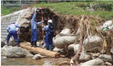
河川構造物の被害状況調査(添田町)
