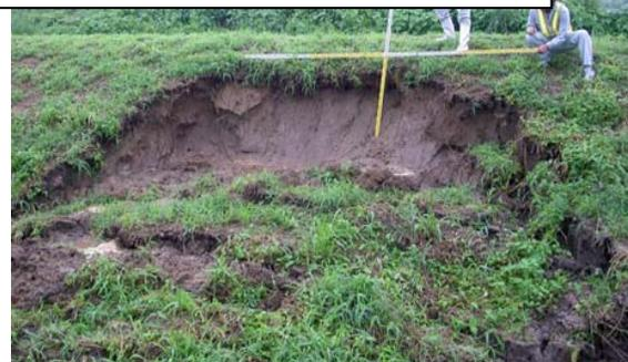
平成21年洪水 城原川左岸 6k400付近 堤防法面崩壊状況
