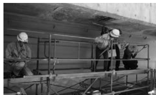
文部科学大臣賞 大学研修施設(大規模実橋モデル)を活用した「臨床型」の橋梁維持管理技術者育成 名古屋大学大学院 工学研究科土木工学専攻 橋梁長寿命化推進室
