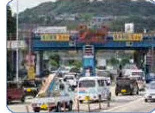
写真①国道2号 関門トンネル(下関側)
