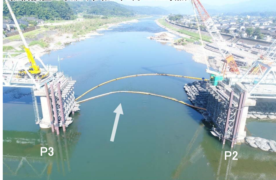
現在、500tクレーンによるベント設置中
