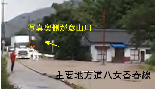
【写真①(家屋浸水状況)】
