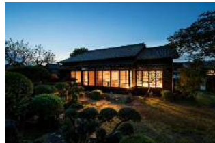
かつめてい 宿泊施設に改修した勝目邸
