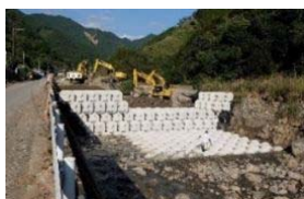
【仮設土砂止め】
