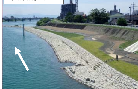
堤防補強状況 (R2.6)
