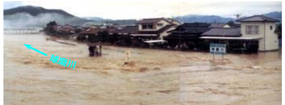
人吉市相良町の浸水状況
