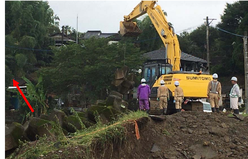
緊急復旧状況
