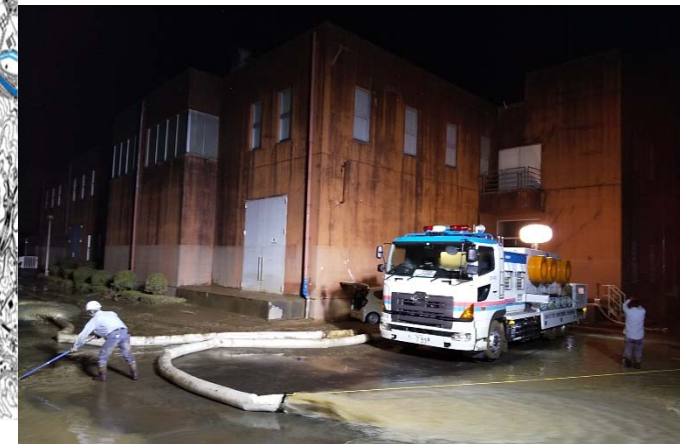
排水ポンプ車による排水作業（7月5日未明）
