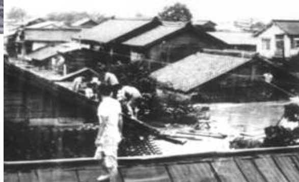
人吉市青井町の浸水状況
