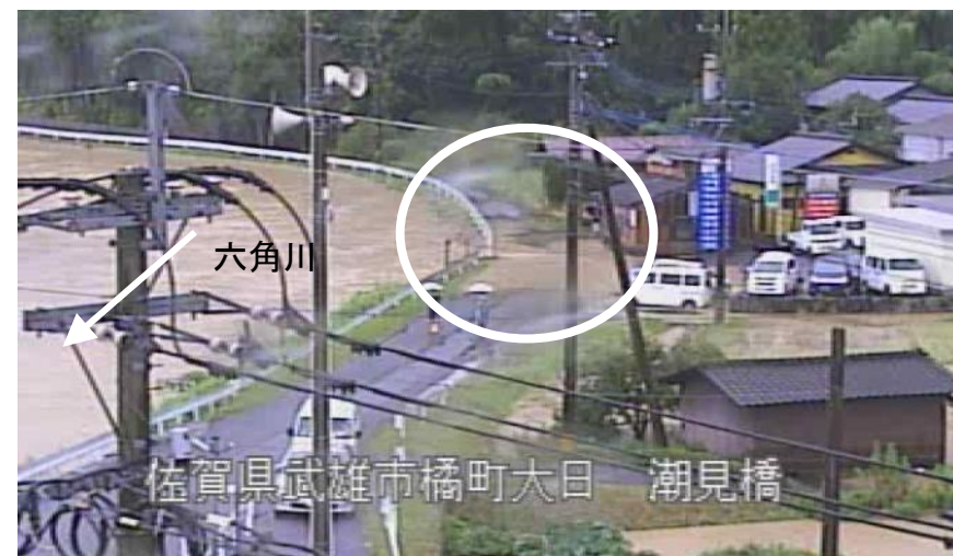
④ 8/14 7:40頃 六角川30k400付近 潮見橋上流付近(溢水状況)
