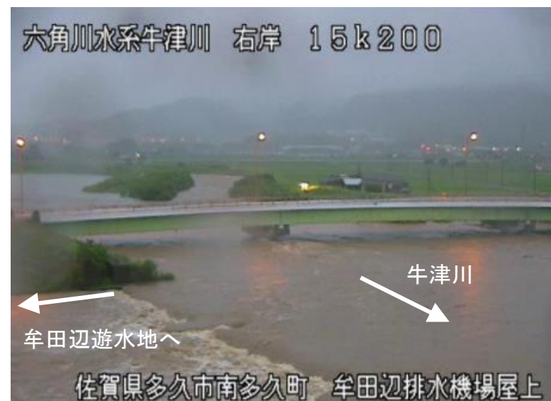
② 8/14 6:00頃 六角川15k200付近 牟田辺遊水地への流入状況
