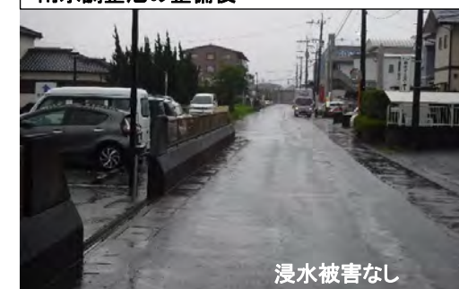
雨水調整池の整備後
