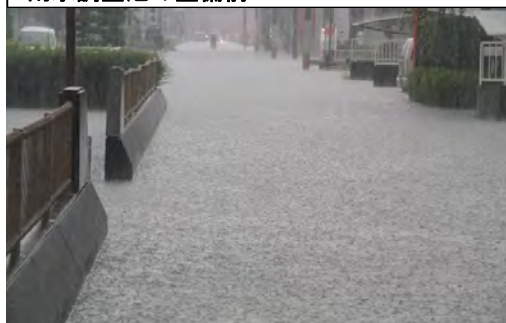
雨水調整池の整備前
