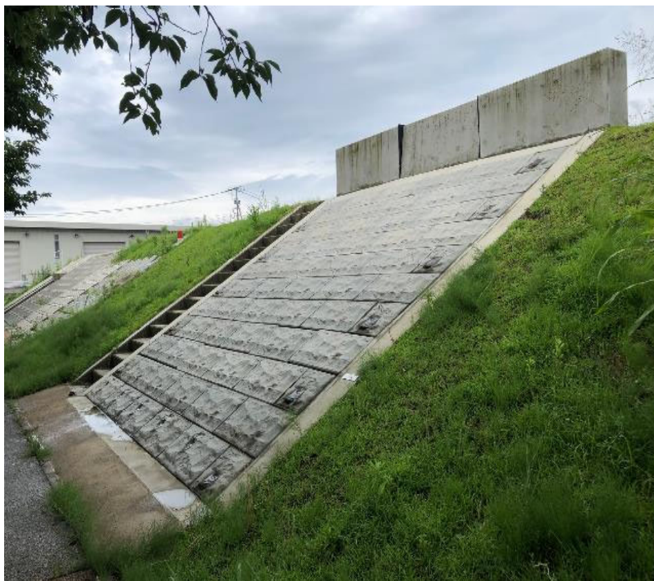
九州技術事務所 研修用堤防
