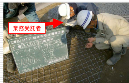
（河川護岸用かごマットの材料確認）
