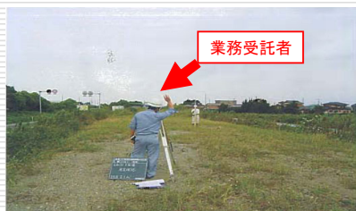
（現場状況の照合を実施）
