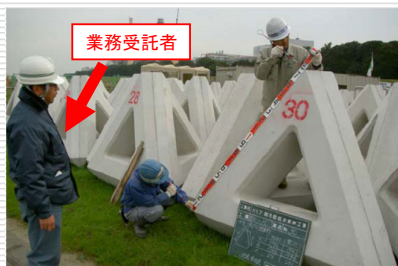
（根固めブロックの材料確認）
