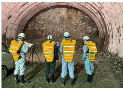
【立会状況（現場側）】
