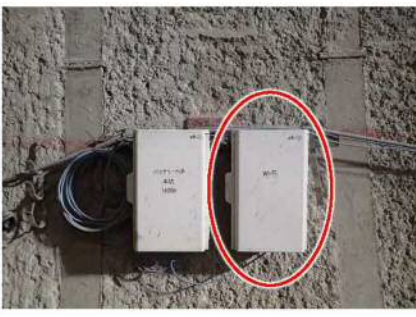
【遠隔臨場用の坑内Wi-Fiの設置（現場側）】
