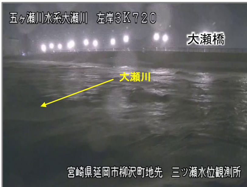
大瀬川3k720付近 洪水状況（9月19日01:00頃）
