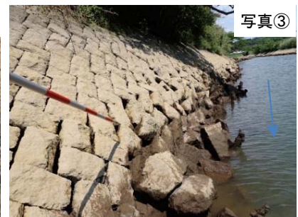
石積みのすべり
