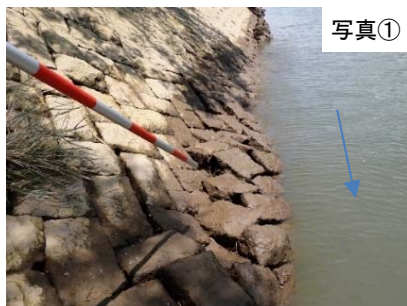
石積みのはらみ出し
