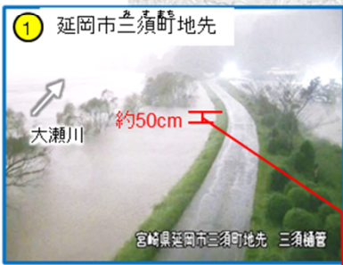
堤防天端まで約50cmの水位を記録
