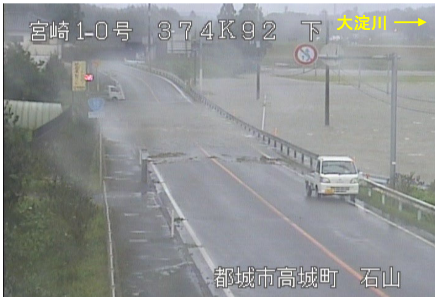
大淀川右岸59k000付近 堤内側を望む (9月19日06:00頃)
