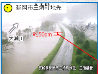
堤防天端まで約50cmの水位を記録
