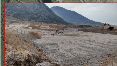
無人化施工現場(10分)
