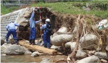
河川構造物の被害状況調査(添田町)
