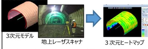
3次元モデルと3次元計測を連携することで、施工エリアの面的管理を実現、施工の実施状況の把握及び出来形管理の効率化を図る
