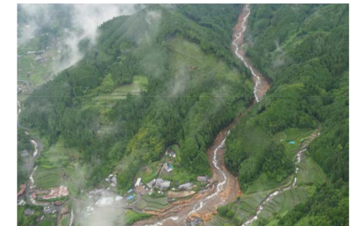
土石流等の発生状況 福岡県東峰村
