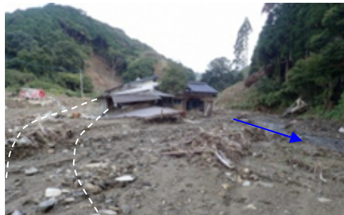
河道の埋塞状況
