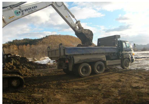
ダンプトラックへ積み込み、
