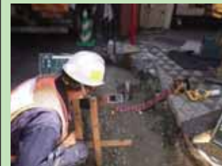
【検査状況（現場側）】
