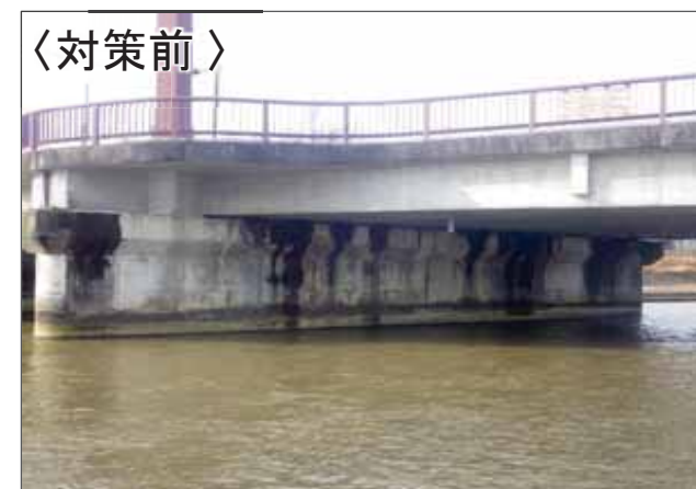
横変位拘束装置設置等の耐震対策
