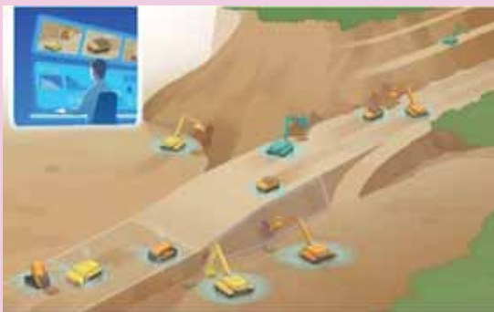
自動化建設機械による施工
