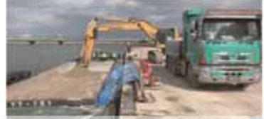
淀川左岸線工事における船舶の利用
