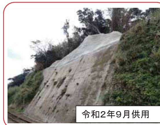
法面对策を実施した結果、被害なし (令和4年9月台風)
