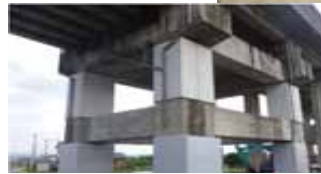
鋼板巻きによるラーメン橋台の耐震対策
