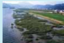
河道掘削による湿地再生 (円山川、兵庫県豊岡市)
