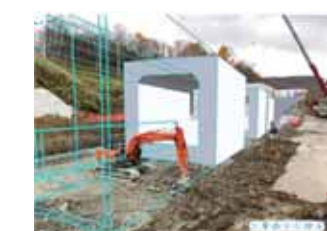
掘削作業時にARと比較
