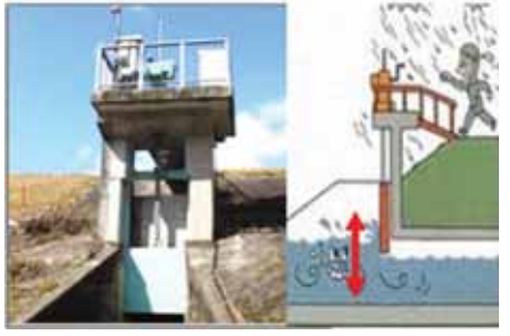
モーターでゲートを上下に開閉
