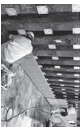
農林水産大臣賞 パナソニック工法「ストパネ」工法による 腐食・剥落・水路の補修・迅速再生 技術の開発 藤村クレイト株式会社
