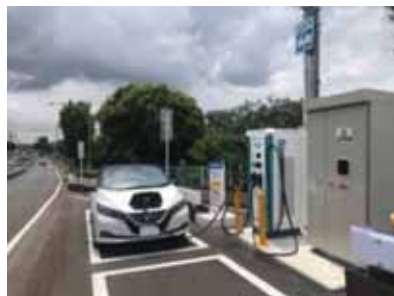
道路上に設置されたEV充電機器 (横浜市)
