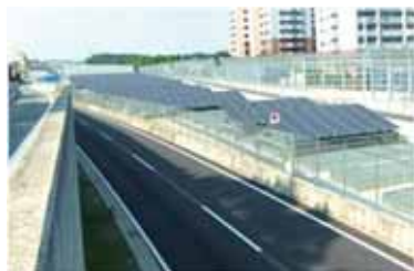
道路での再エネ発電量：約1.3万MWh (道路管理の消費電力の約0.4%)
