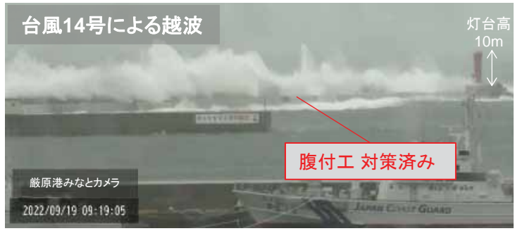
【整備後：令和4年台風第14号による防波堤（北）の状況】
