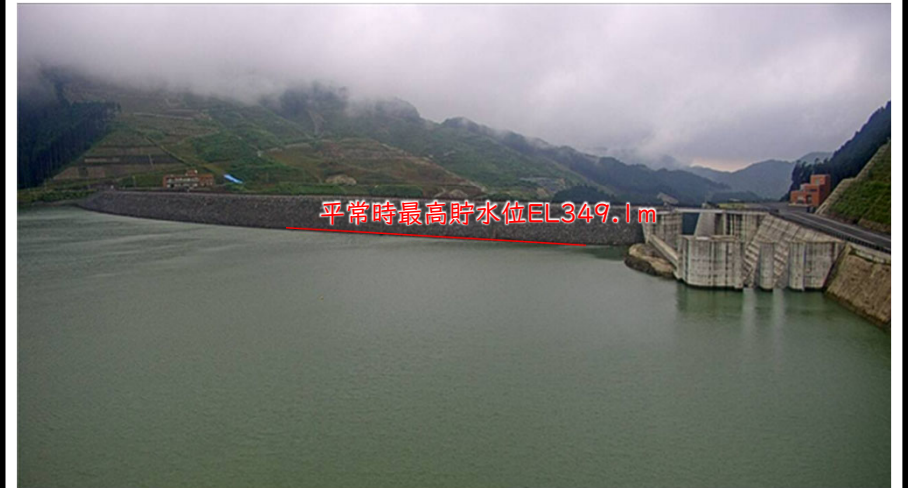
平常時最高貯水位付近の状況(R5.7.5:EL349.15m)
