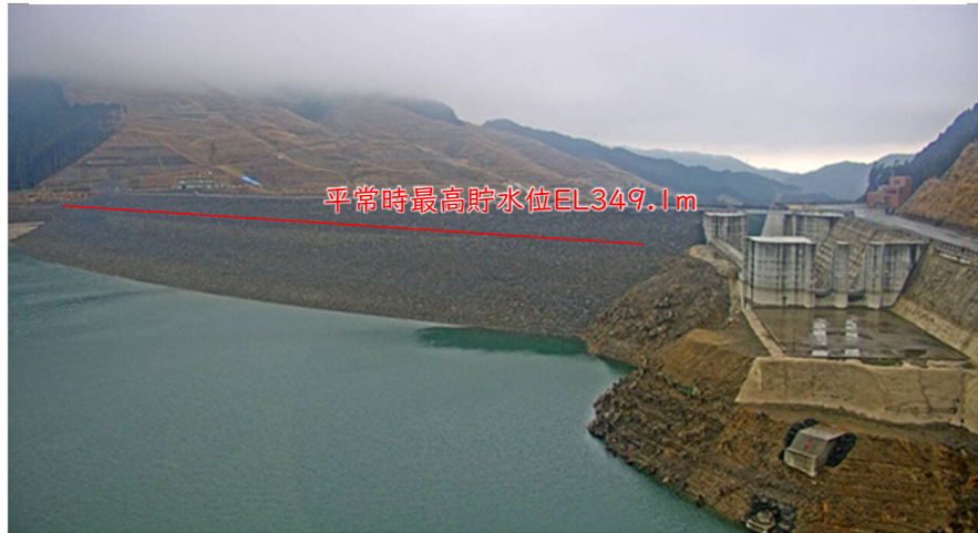
小石原川ダム現状(R5.12.15:EL329.56m)
