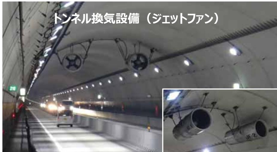
トンネル内を換気することで排気ガス等で見づらいトンネル内の視界を確保するとともに、車両火災時等での救助活動時に活躍します。
