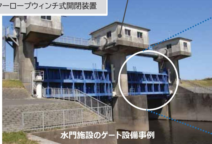
ゲート本体（青色の部分）をワイヤーロープ式の開閉装置やラック棒を利用した開閉装置によってゲート本体を上下させます
