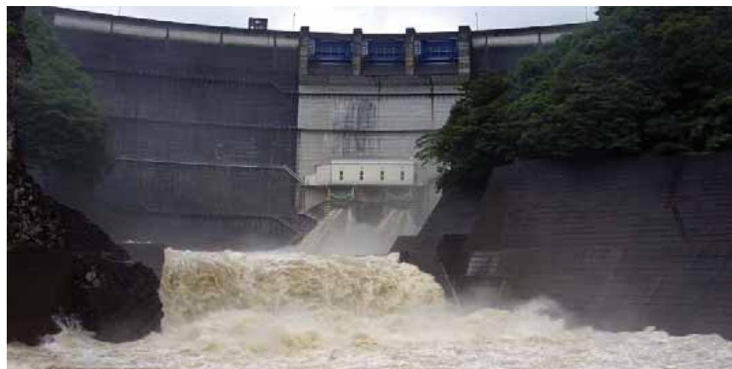
大雨による洪水時のダム放流設備からの放流状況
