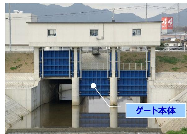
※ゲート設備構成 = ゲート本体 + 開閉装置 + 操作制御装置
