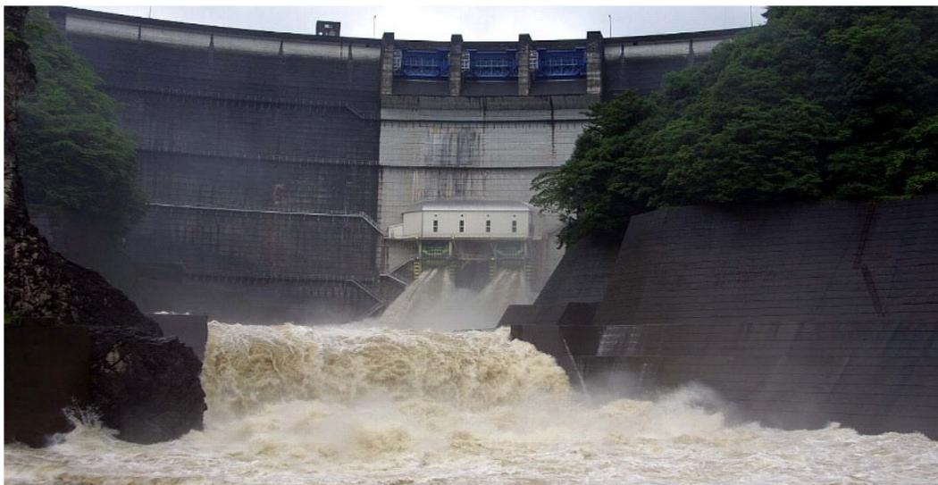
大雨による洪水時のダム放流設備からの放流状況
