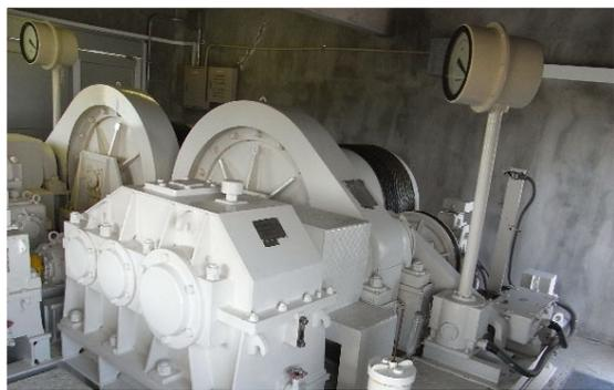
ワイヤーロープウィンチ式開閉装置
