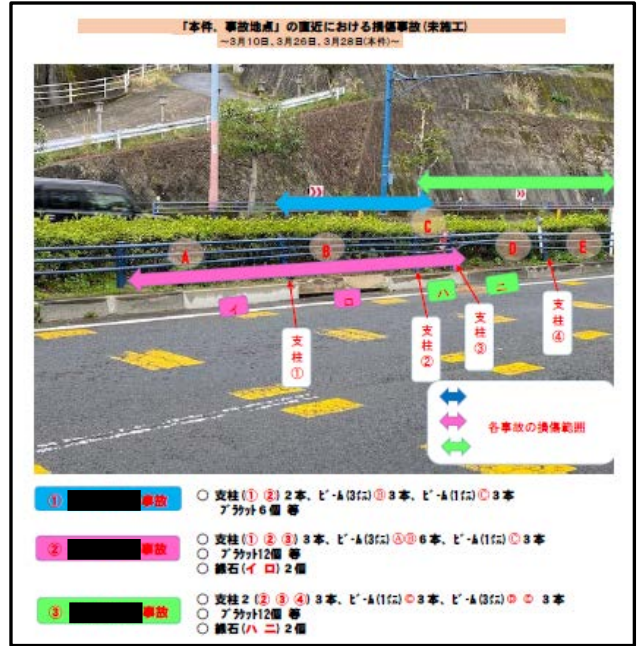
写真-4 直近3か所で起こった損傷事故
