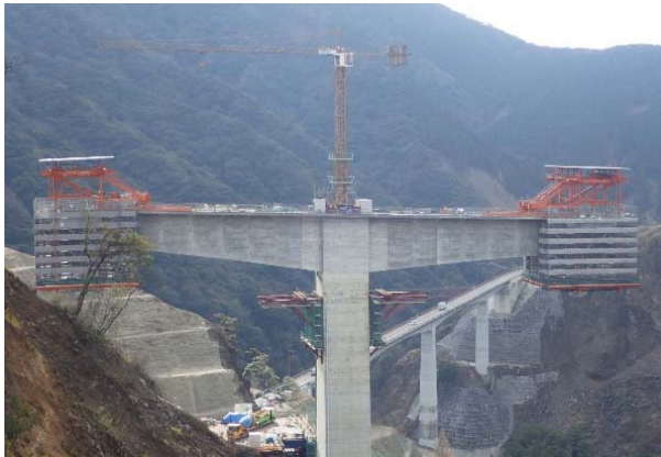
図-12 超大型移動作業車を用いた張出施工（PR3 橋脚躯体工）
