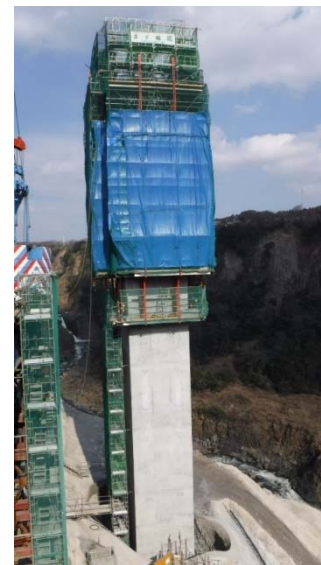
図-11 クライミングシステム工法（PR1 橋脚躯体工）
