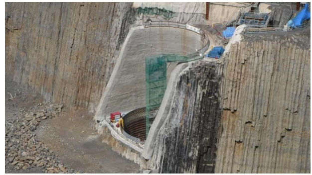
図-10 PR2 橋脚基礎の土留め工及び黒川右岸の柱状節理
