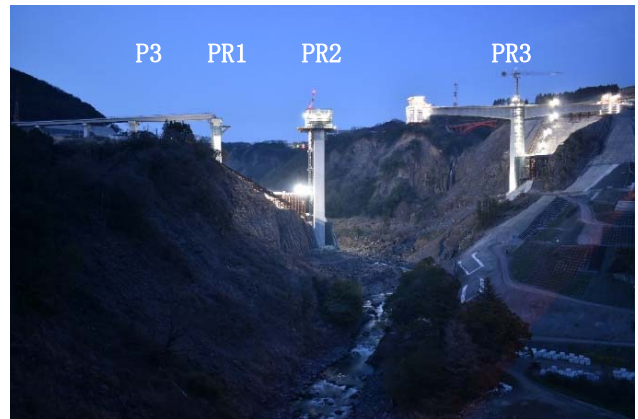
図-14 夜間施工状況
