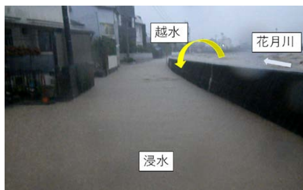
図-1 平成29年7月5日 浸水の様子 花月川3.8kp 左岸(一新橋上流)
