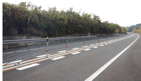
写真6 ワイヤーロープ防護柵の設置状況
