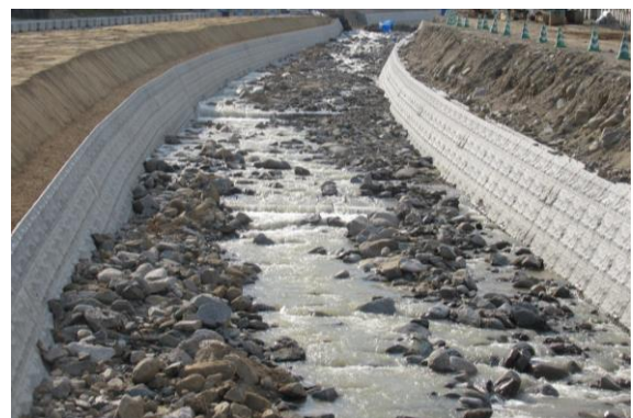
写真-6 現在の乙石川(施工中)
