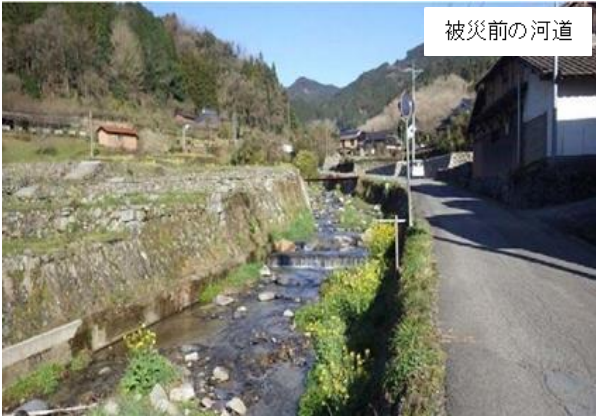
写真-1 被災前の乙石川の河道
