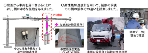
図-8 橋の振動試験実施
