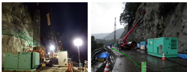
写真-3 昼夜施工状況
