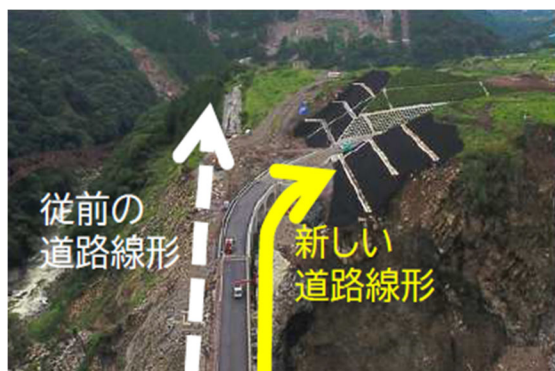
写真-5 A1橋台の線形
