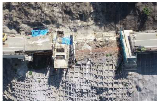
写真-9 戸下大橋の仮橋の撤去状況
