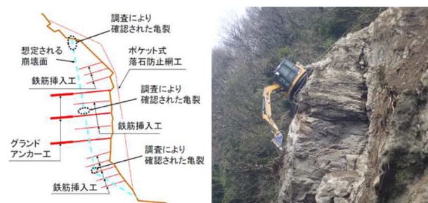
図-10 戸下大橋上部斜面の状況と対策工
