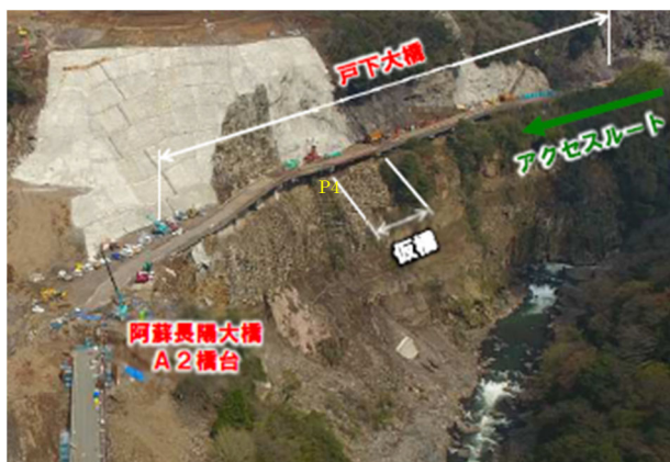
写真-2 戸下大橋の復旧状況
