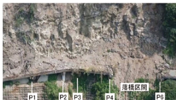
写真-8 戸下大橋の斜面崩落と崩落状況
