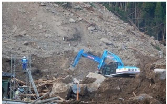
図-2 災害現場における巨石や倒木の除去作業
