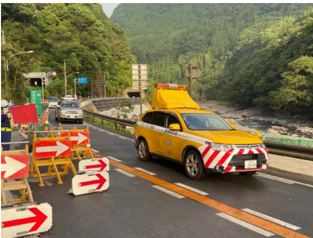
写真-14 全面通行止めの解除の様子
