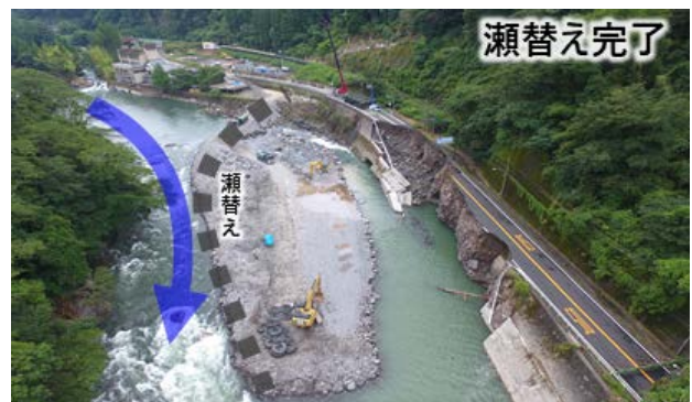
写真7 瀬替え完了後の河川の流れ
