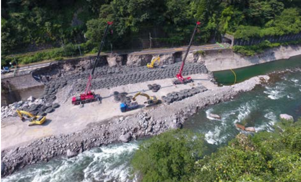
写真-9 袋詰玉石の投入の様子
