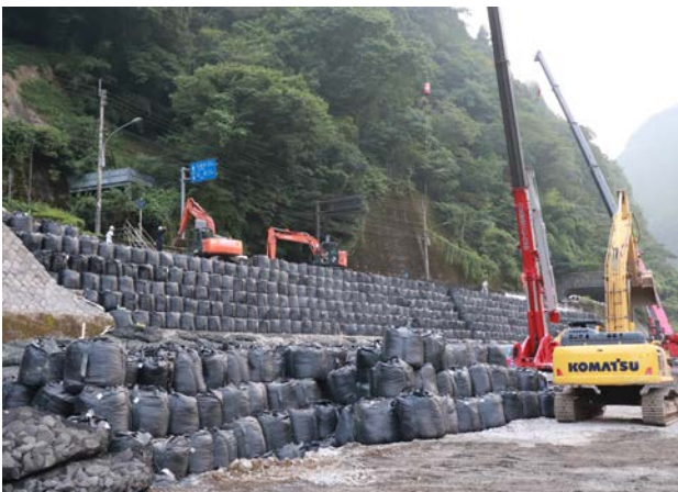
写真-10 大型土のう据付の様子
