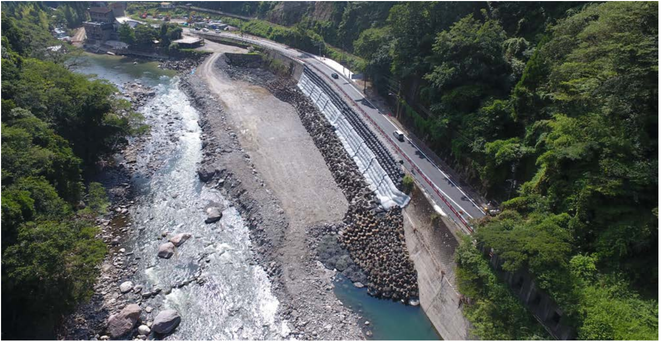
写真-13 応急復旧完了の様子（8月17日10：00）
