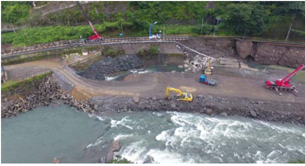
写真-8 造成した施工ヤード
