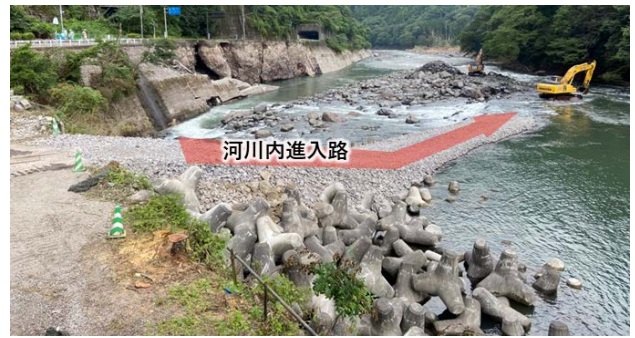
写真5 河川内進入路設置の様子
