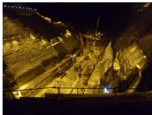
図-9 夜間の立野ダム工事現場
