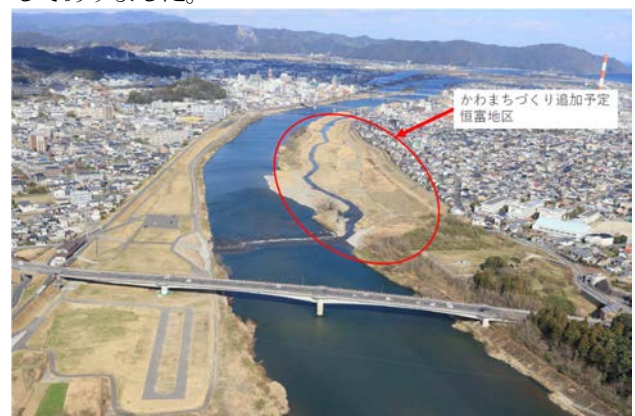
写真-14 かわまちづくり追加予定箇所 (恒富地区 大瀬川右岸地区)
