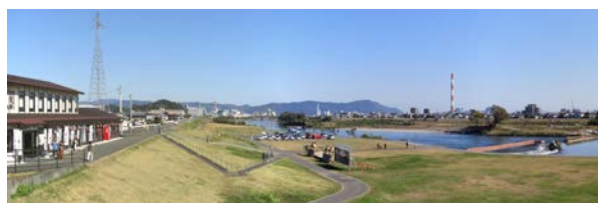
写真11 大瀬川左岸5kのかわまち交流広場
