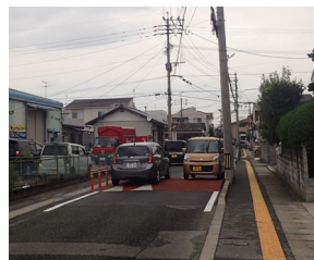
図-7 可搬型ハンプ設置状況 (ひより茶屋前)
