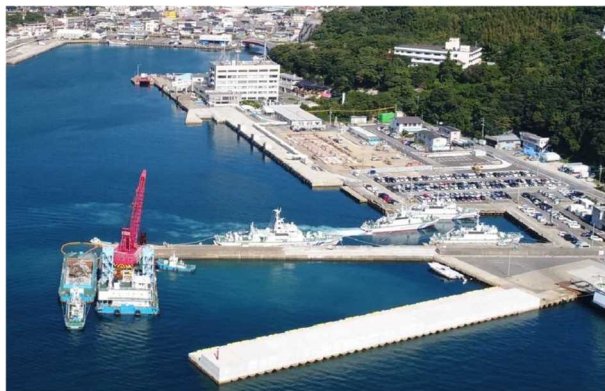
図-17 防波堤撤去状況
