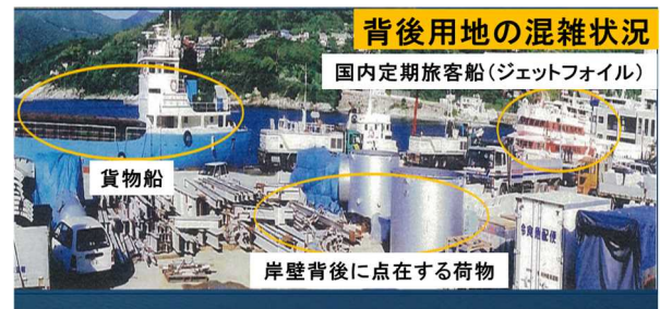
図-2 ターミナル再編前の厳原港背後用地の混雑状況
