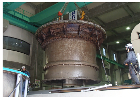
写真-2 (吊り下げケーシング)
