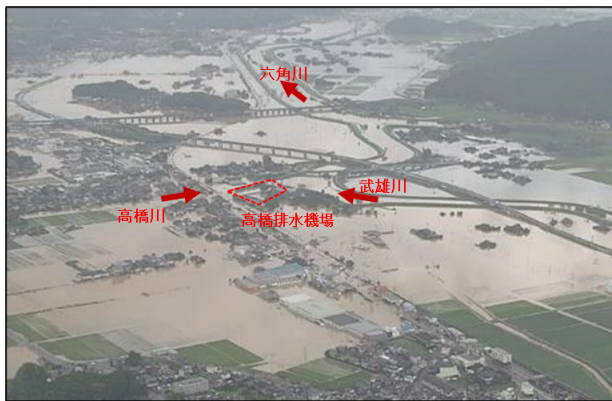
写真-1 R1. 8月出水状況
