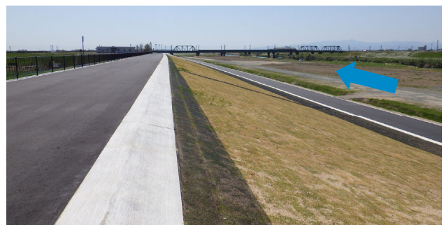
写真-3 施工後風景
