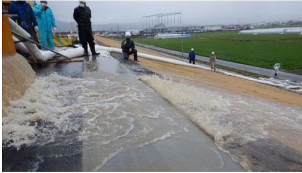
法肩通水状況
