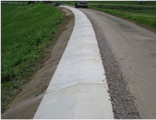
写真-2 路肩保護工
