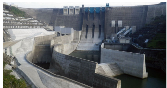
図-2 再開発事業完了後の鶴田ダム
