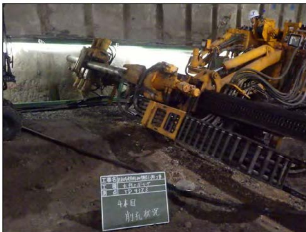
図-8 本坑水抜きボーリング実施状況
