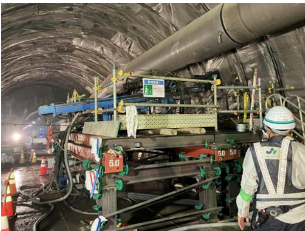
図-16 避難坑水抜きボーリング実施状況
