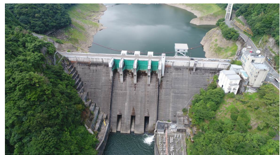
写真-1 松原ダム
