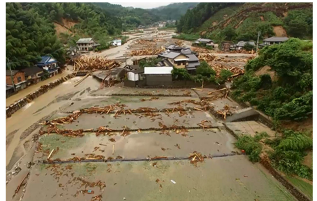
写真-2 赤谷川の被災状況 (H29. 7)
