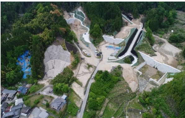
写真-4 崩谷川砂防堰堤 状況写真
