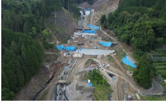
写真-8 乙石上流砂防堰堤 施工状況写真
