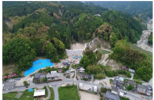
写真-5 県道52号線沿い砂防堰堤 状況写真
