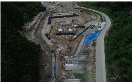
写真-10 乙石川遊砂地 施工状況写真
