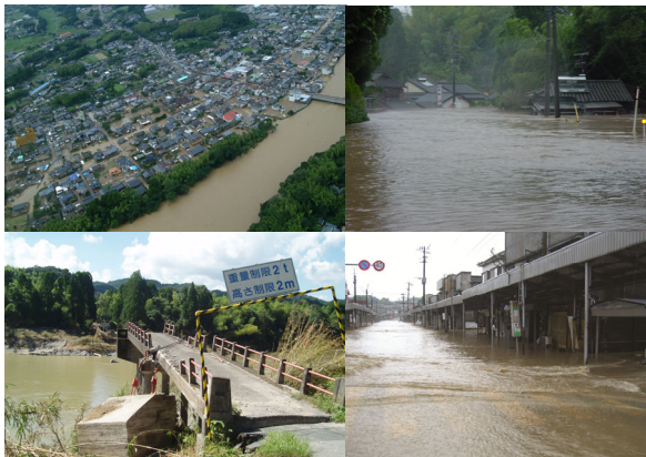
写真-2 平成18年7月洪水の状況写真
