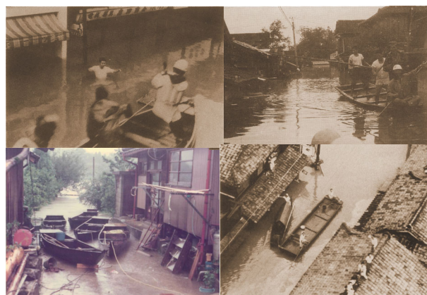
写真-1 川内川流域被災写真
